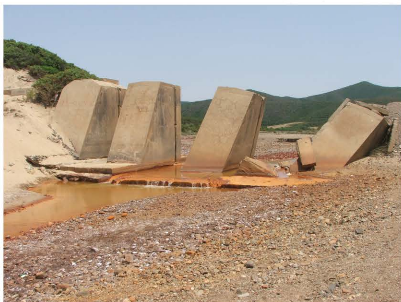
La diga a paratie mobili sul Rio Piscinas, a Montevecchio Ponente. In seguito alle proteste dei gestori delle tonnare, che lamentavano la diminuzione dei tonni pescati a causa della torbidità dell'acqua, nel periodo del passaggio dei tonni sottocosta le paratie venivano chiuse e i residui di flottazione trattenuti entro l'impluvio del fiume; a conclusione delle mattanze le paratie venivano aperte e i fanghi di flottazione lasciati defluire in mare, liberando lo spazio nell'impluvio per l'anno successivo.
